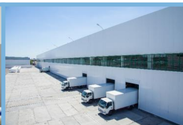
Bens e Instalações
