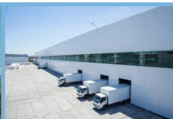
Bens e Instalações
